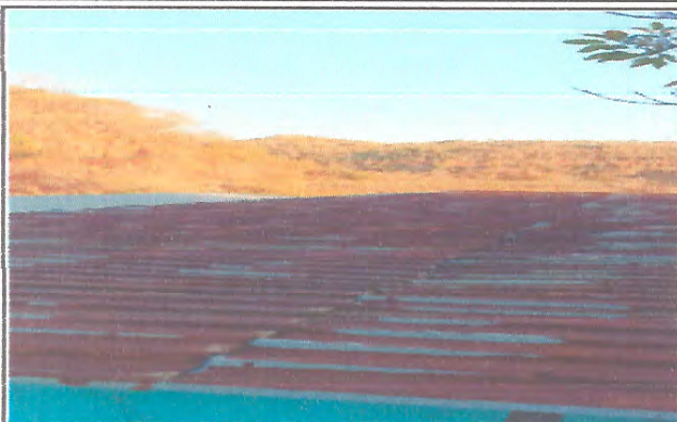
Foto 1: MANTENIMIENTO DE CUBIERTA DE LAMINA.
