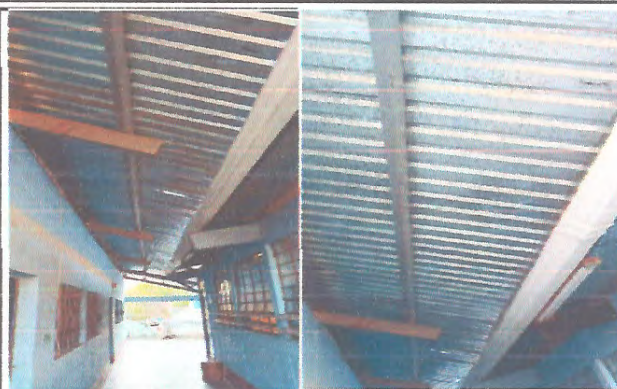
Foto 2: MANTENIMIENTO DE CUBIERTA DE LAMINA.
