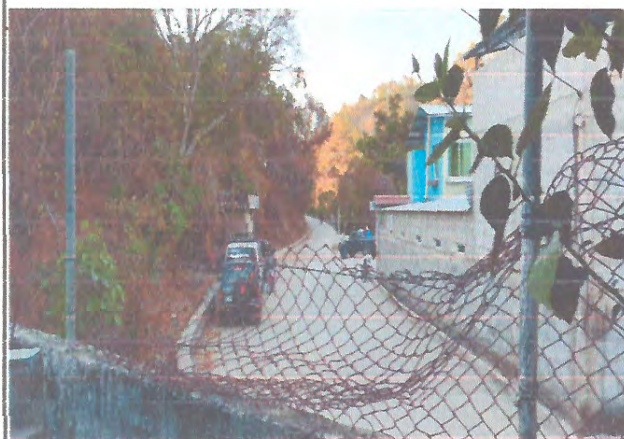
Foto 3: MANTENIMIENTO DE MURO PERIMETRAL.
