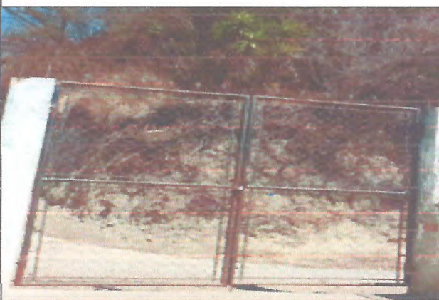
Foto 4: MANTENIMIENTO DE PORTÓN
